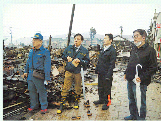
火災のあった輪島市の中心部を調査する井上氏(左から2人目)=2024年1月3日、石川県輪島市
